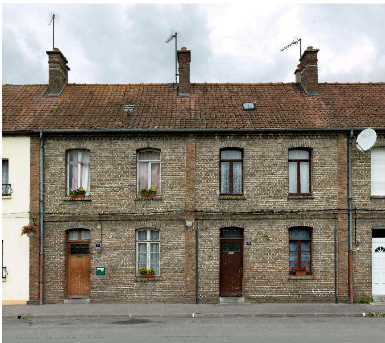
Façade sur rue des logements de cadre.
