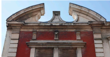
Vue sur le fronton curviligne interrompu. Phot. Pierre Thibaut IVR31_20096200285NUCA
