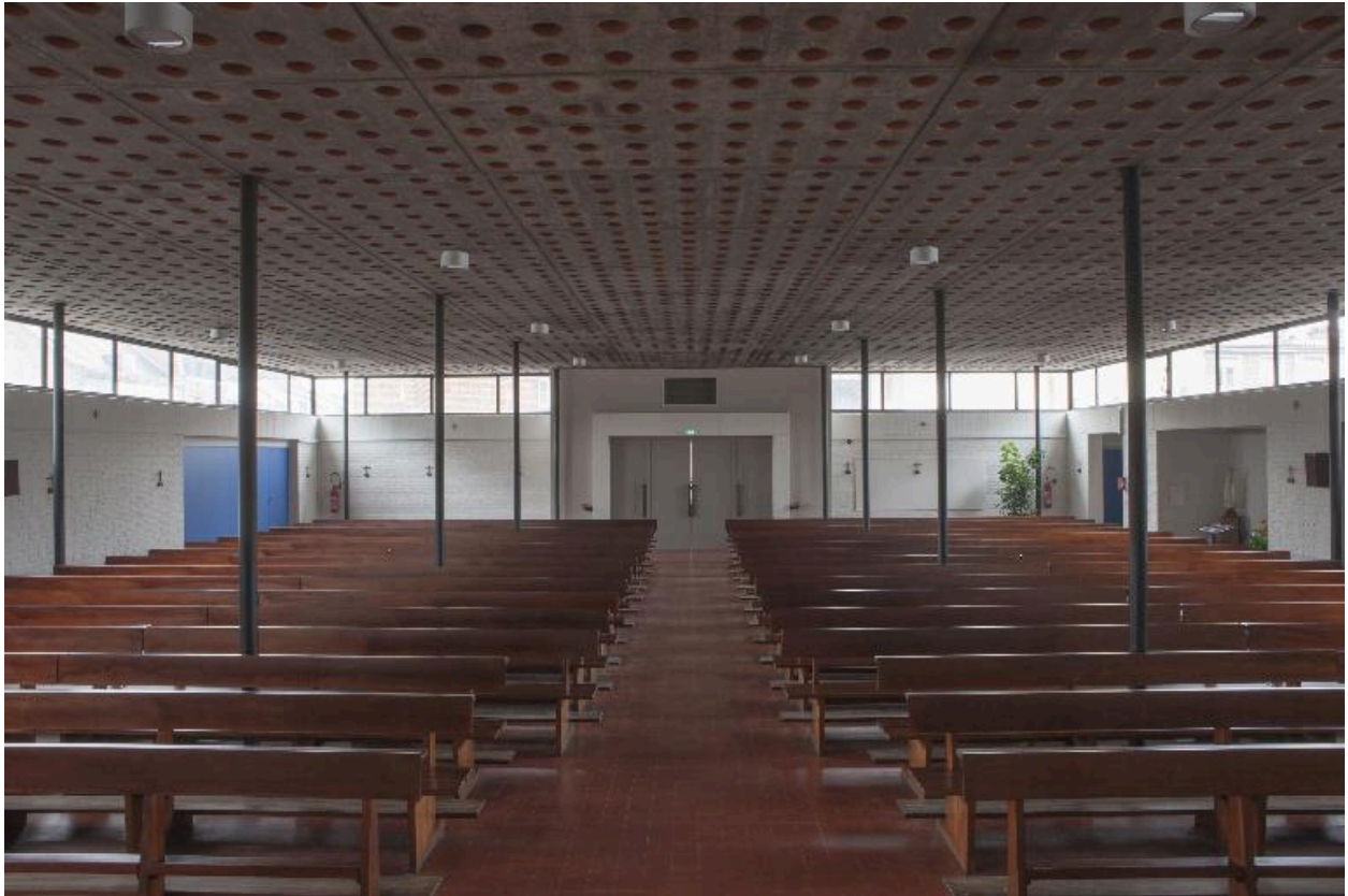
Vue générale depuis le chœur.
