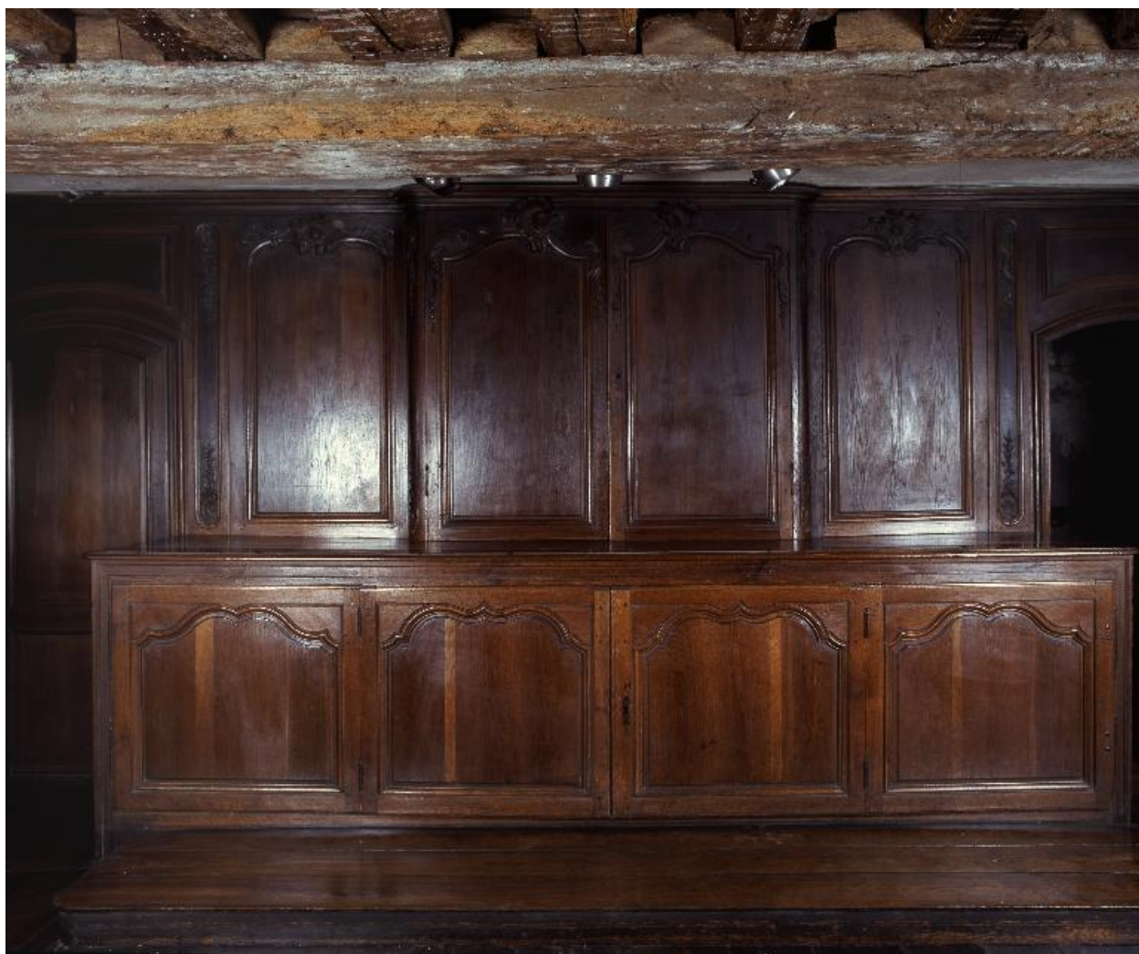
Vue de détail : placards au premier plan.
