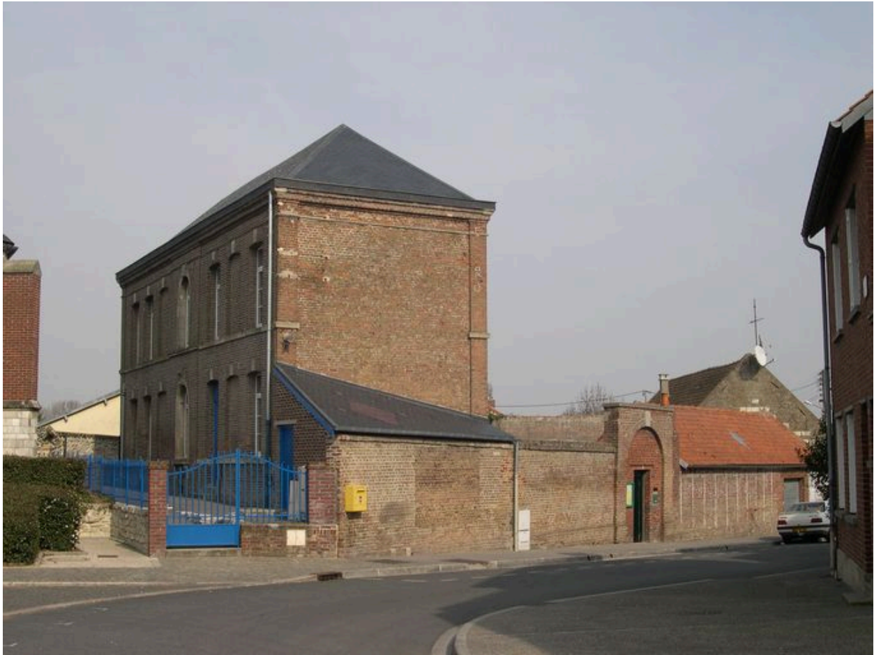
Le presbytère, vue depuis le sud.
