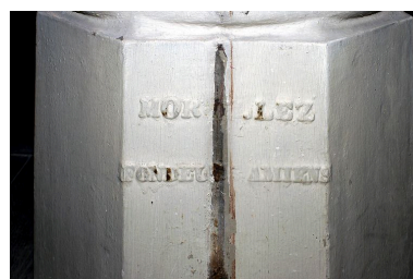
Vue de détail : pilier en fonte. Phot. Thierry Lefébure IVR22_20068000208NUCA
