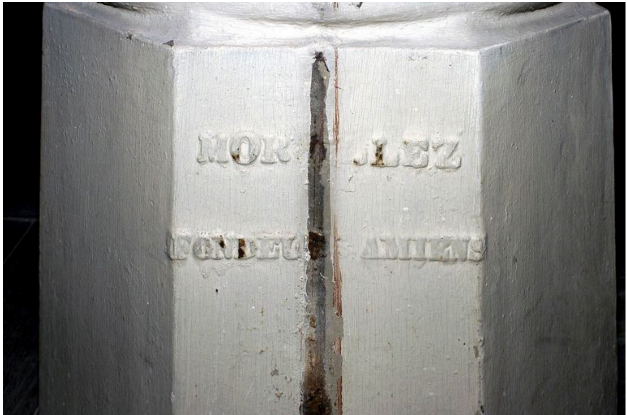
Vue de détail : pilier en fonte.
