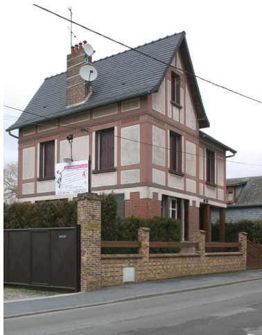
Le logement de contremaître. Phot. Frédéric Pillet IVR22_20060205029NUCA
