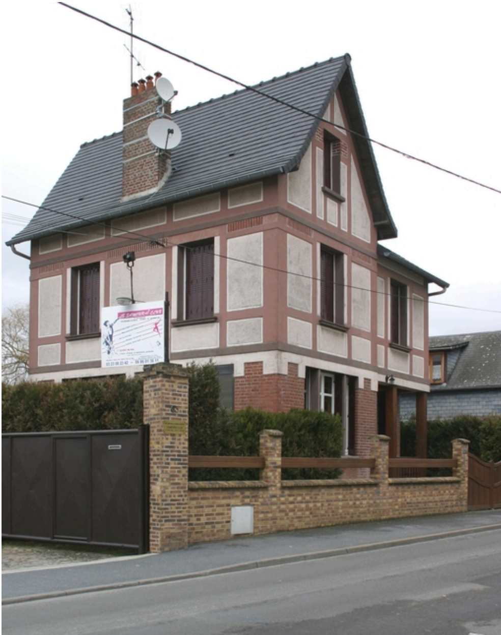
Le logement de contremaître.
