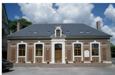
Élévation principale sur la cour.
