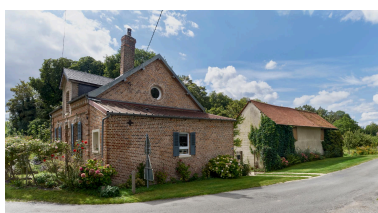
Maison d'habitation et bâtiment agricole, vue prise depuis l'est. Phot. Thierry Lefébure IVR32_20238000460NUCA
