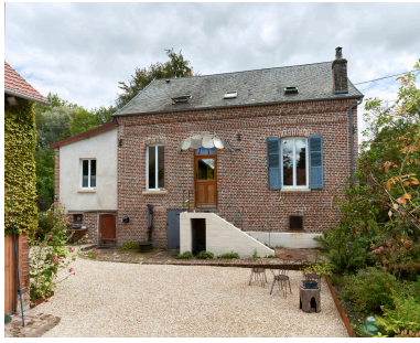
Maison d'habitation, vue prise depuis l'ouest. Phot. Thierry Lefébure IVR32_20238000462NUCA
