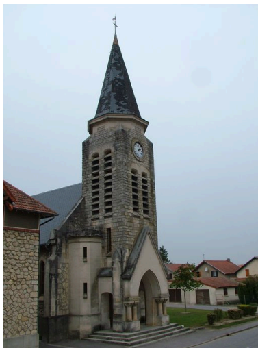
Vue de la façade ouest. Phot. Inès Guérin IVR22_20030203141NUCA
