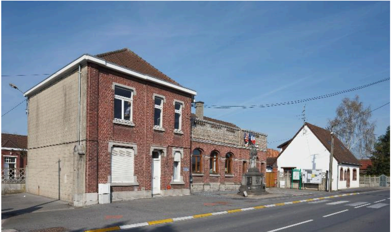
Vue générale de l'actuelle mairie - précédé du monument aux morts - et l'ancien logement d'instituteur, depuis la rue.
