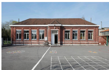
Vue générale d'une salle de classe et le préau. Phot. Hubert Bouvet IVR31_20105900126NUCA
