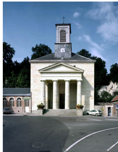
Vue générale. Phot. Thierry Lefébure IVR22_20038000780VA
