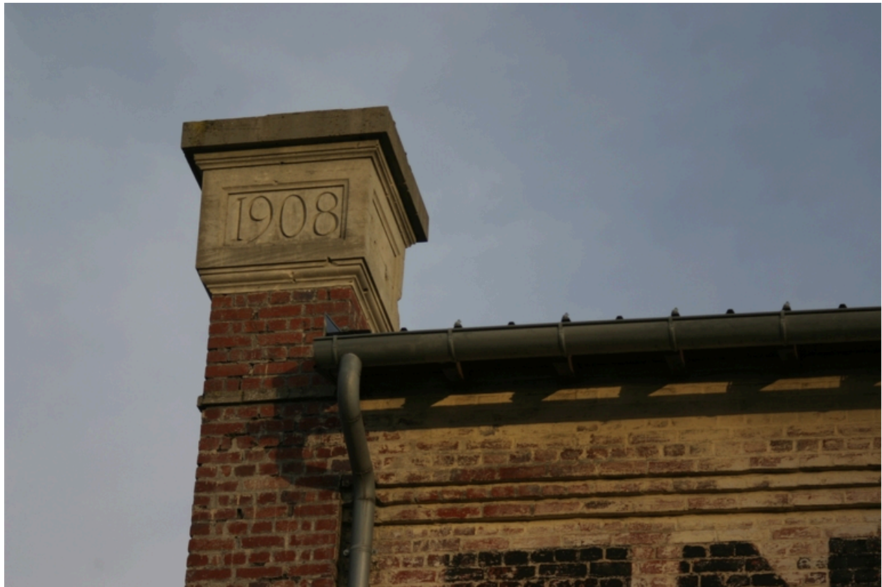
Détail d'un acrotère portant la date 1908.
