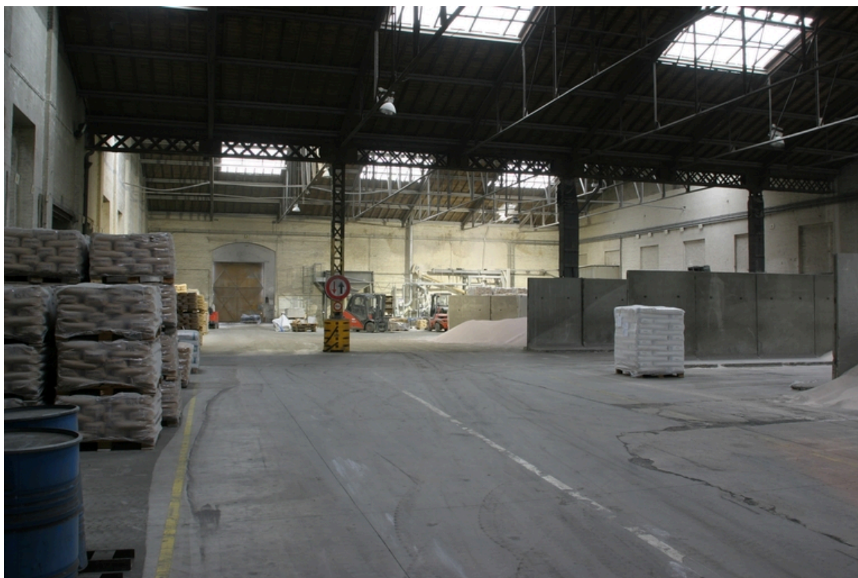
Vue intérieure des halles de 1908.
