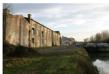
Façade des halles de 1908 en bordure du Canal de Saint-Quentin. Phot. Frédéric Pillet IVR22_20070205001NUCA
