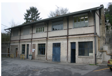
Façade sur cour des bureaux. Phot. Frédéric Pillet IVR22_20070205009NUCA
