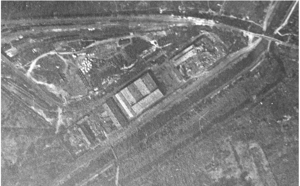
Vue aérienne du site en juin 1918 (AD Aisne).
