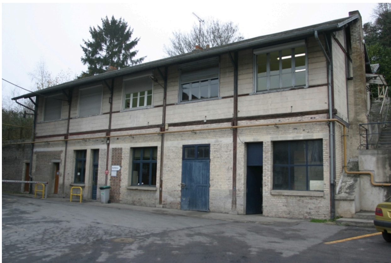
Façade sur cour des bureaux.
