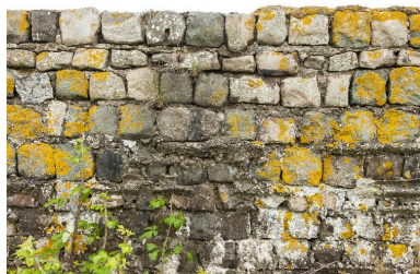
Détail de l'essentage de pavé de l'élévation nord-ouest Phot. Jean-Marc Ramette IVR31_20145905378NUCA
