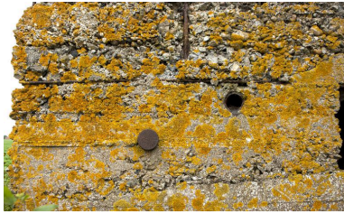
Elévation sud-ouest, détail Phot. Jean-Marc Ramette IVR31_20145905379NUCA
