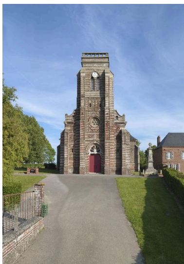
Vue depuis la place Camille-de-Mons. Phot. Thierry Lefébure IVR22_20158000413NUC2A
