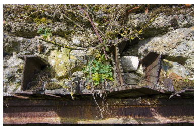
Fers de soutènement en I de la partie est de l'édifice Phot. Jean-Marc Ramette IVR32_20165901136NUCA
