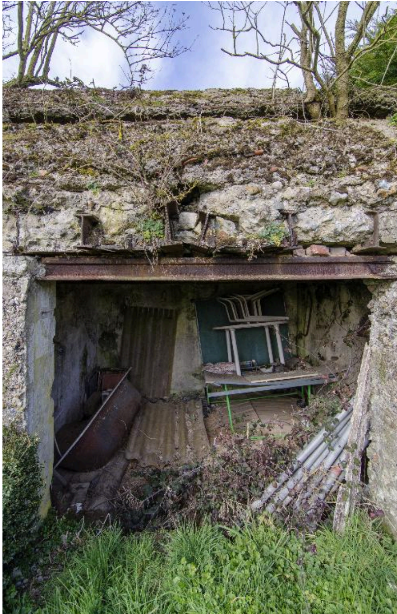
Accès à la partie est de l'édifice.
