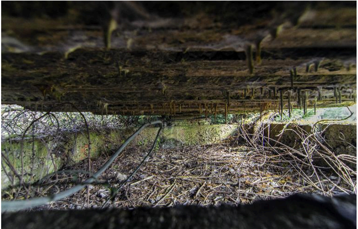
Depuis la tour d'observation, vue intérieure du double couverture de la partie est de l'édifice, servant de chambre d'explosion
