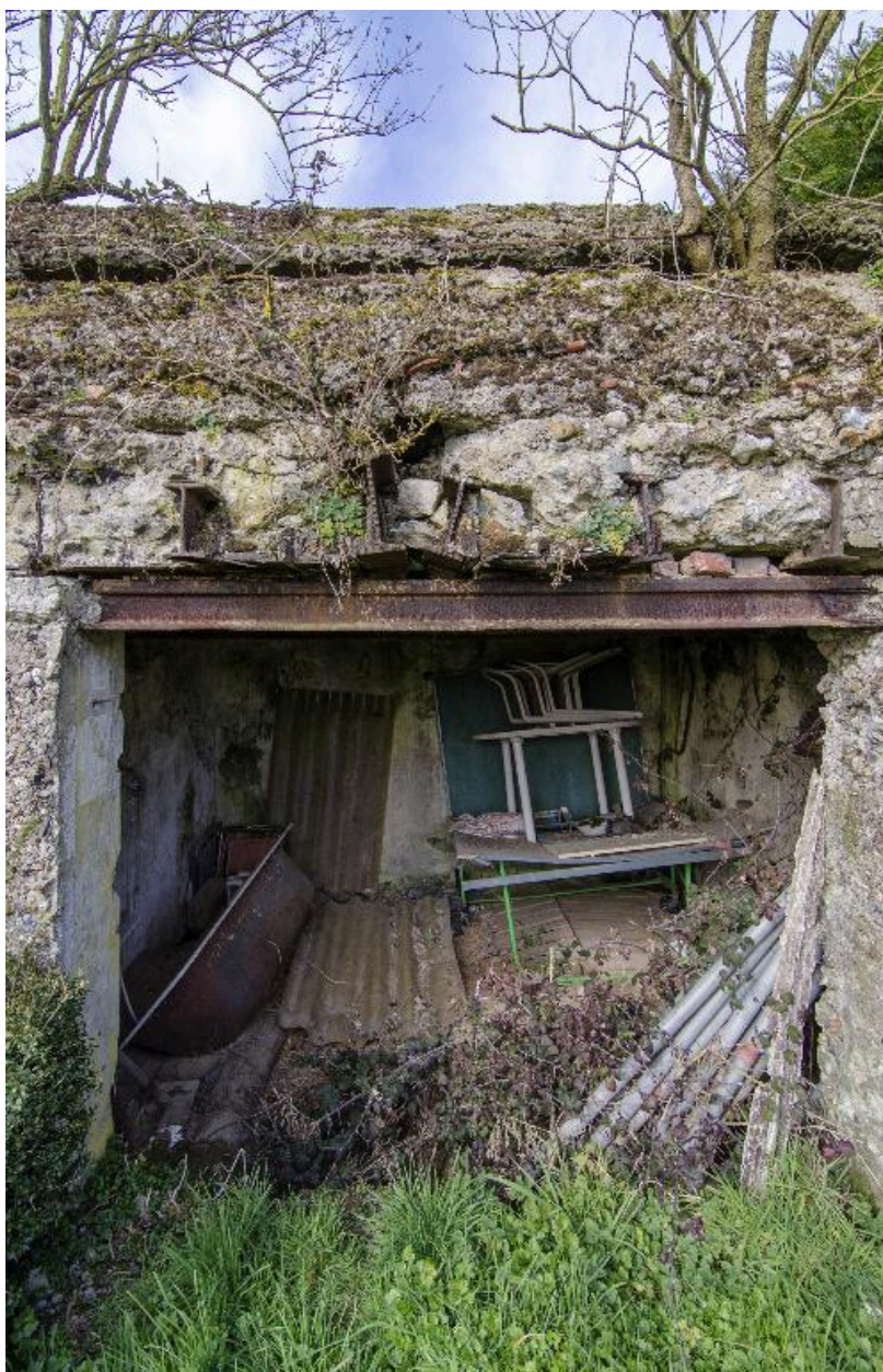
Accès à la partie est de l'édifice.
