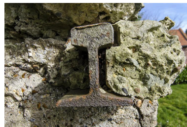
Profil d'un rail servant de soutènement longitudinal aux fers en I Phot. Jean-Marc Ramette IVR32_20165901137NUCA
