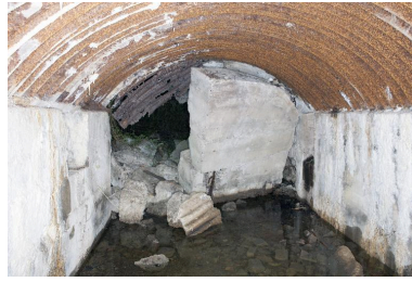
Vue intérieure, vers l'ouest Phot. Pierre Thibaut IVR31_20155900617NUCA
