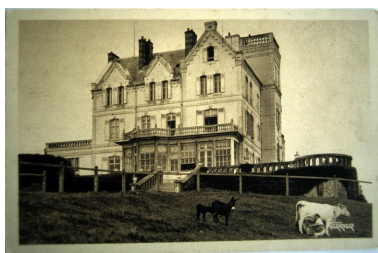
Façade sur mer, carte postale, 2e quart 20e siècle (coll. part.). Phot. Monnehay-Vulliet Marie-Laure IVR22_20058000652XAB
