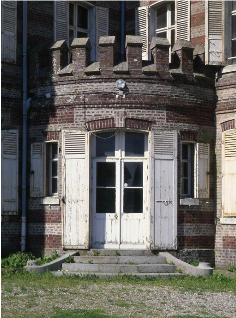
Détail du porche hors-oeuvre comportant l'entrée.
