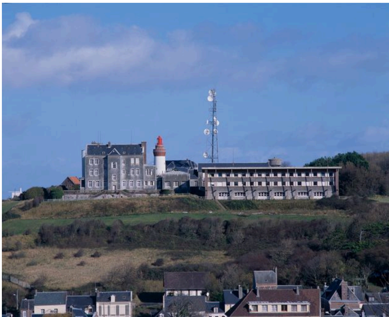
Vue d'ensemble depuis le lotissement du Bel-Air.
