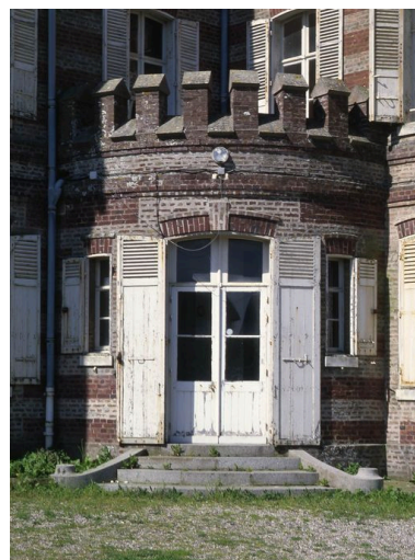
Détail du porche hors- oeuvre comportant l'entrée.
