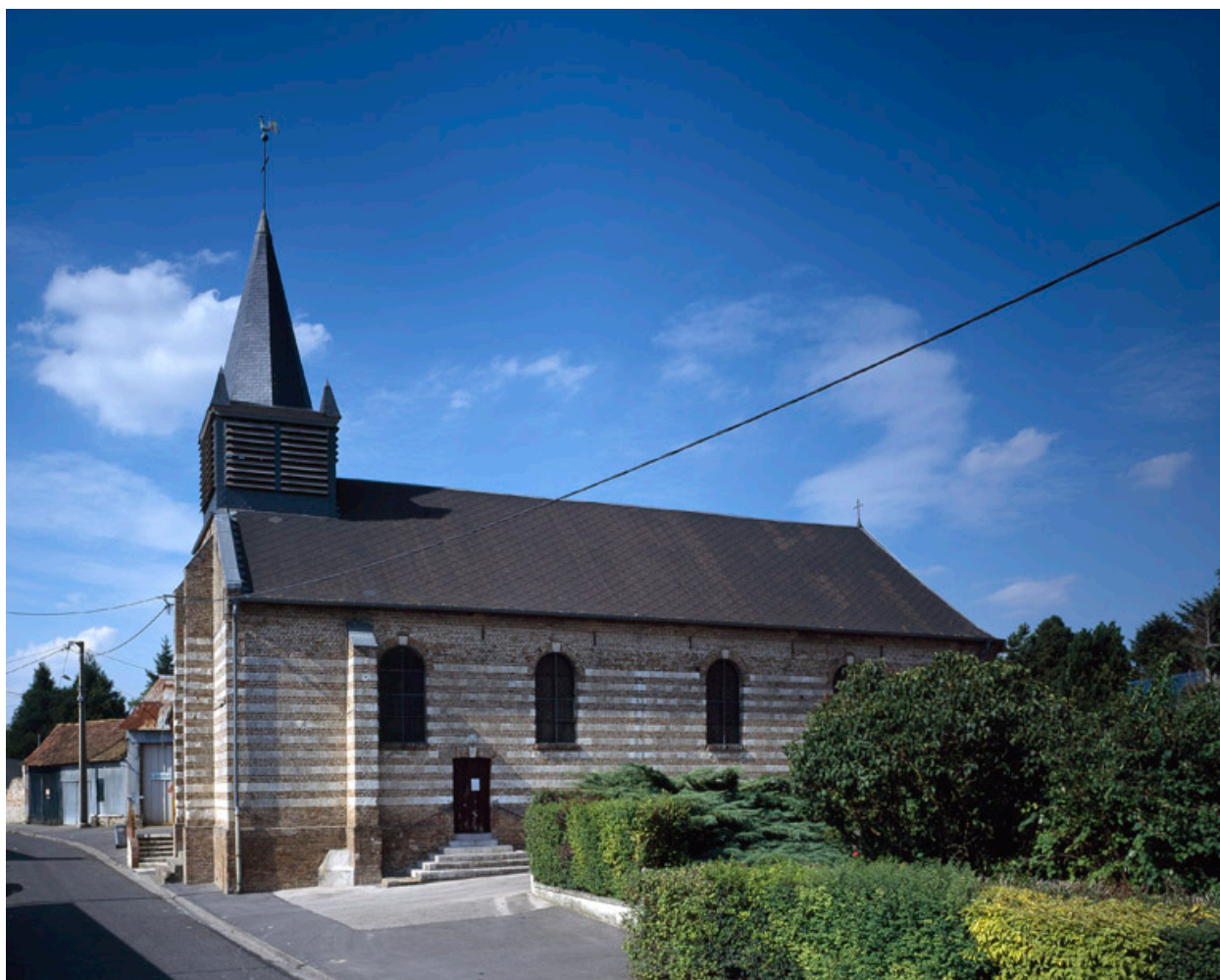
Vue générale depuis le sud.
