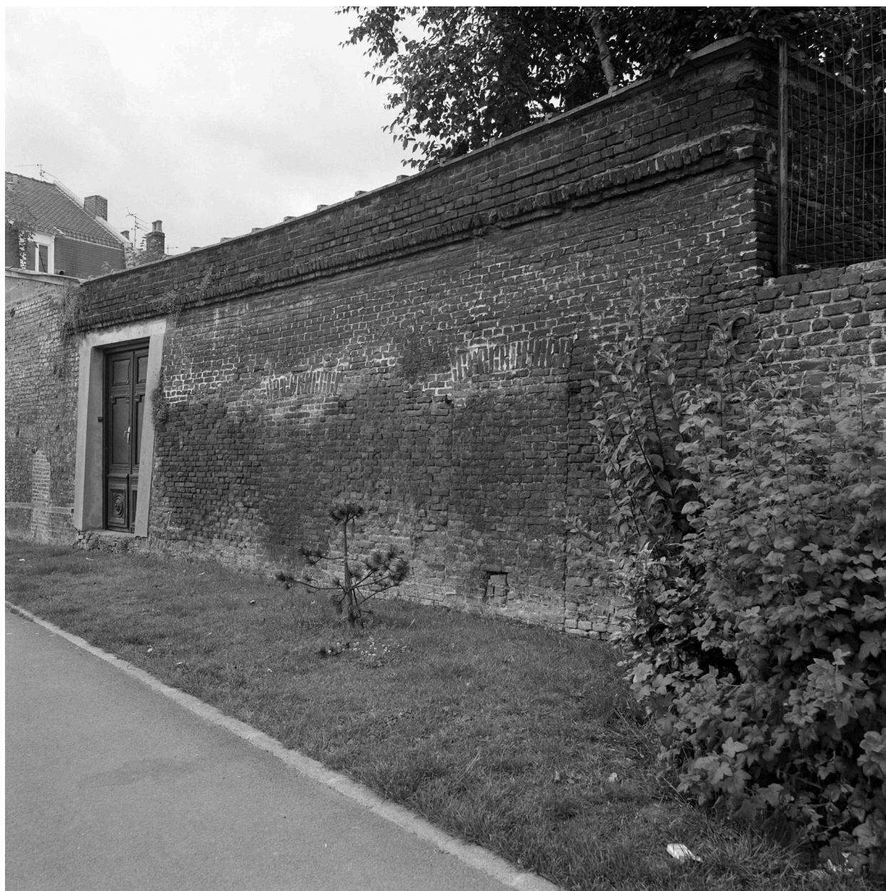
Mur d'enceinte sur l'ancienne Lys.
