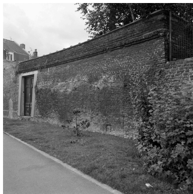
Mur d'enceinte sur l'ancienne Lys. Phot. Philippe Dapvril IVR31_19885901339X
