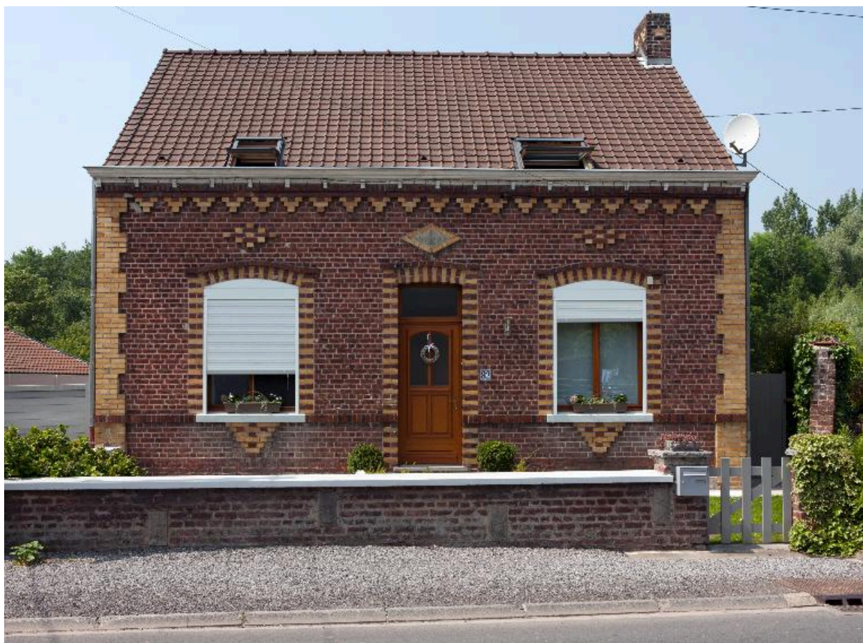
Vue générale de deux maisons de bateliers.
