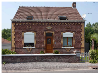
Vue générale de deux maisons de bateliers. Phot. Pierre Thibaut IVR31_20125901767NUCA
