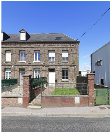
Vue d'un des logements. Phot. Thierry Lefébure IVR22_20158000386NUC2A
