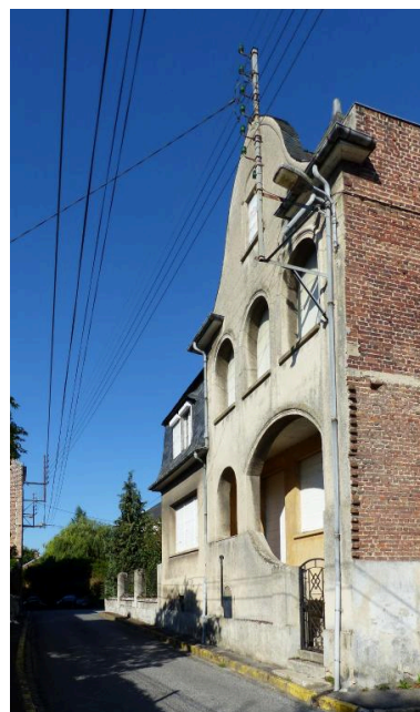
Accès rue des Chanoines. Phot. Isabelle Barbedor IVR32_20178005308NUCA
