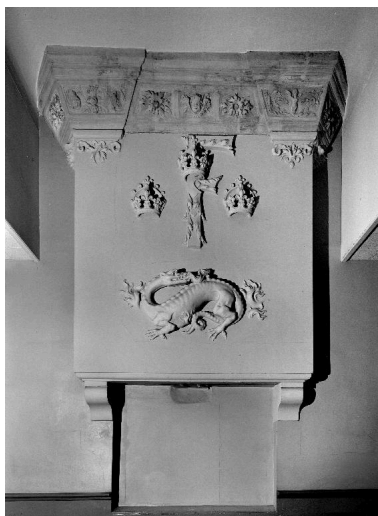
Vue générale de la cheminée. Phot. Thierry Lefébure IVR22_19910200099V
