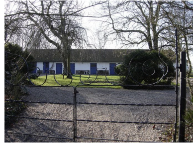
Vue des dépendances depuis la cour. Phot. Catherine Fourmond IVR22_20058001441NUCA
