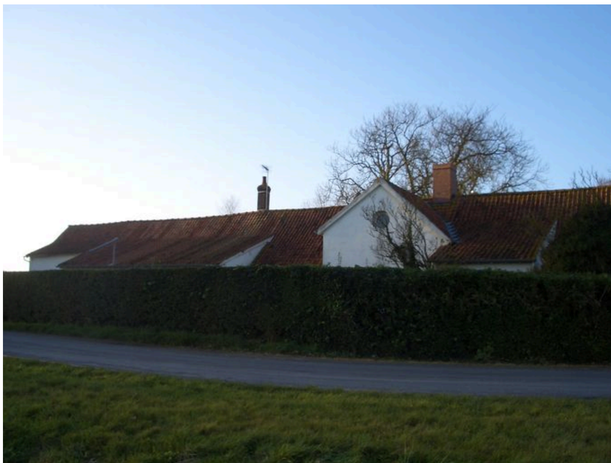
Vue postérieure du logis.
