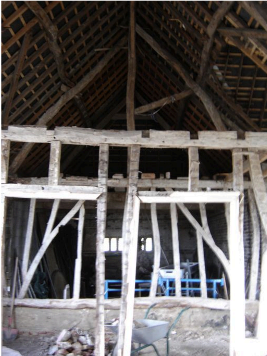
Autre vue intérieure, avec détail de la charpente.
