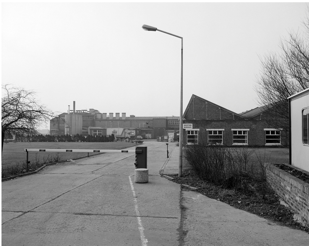
Bureaux, atelier de fabrication.
