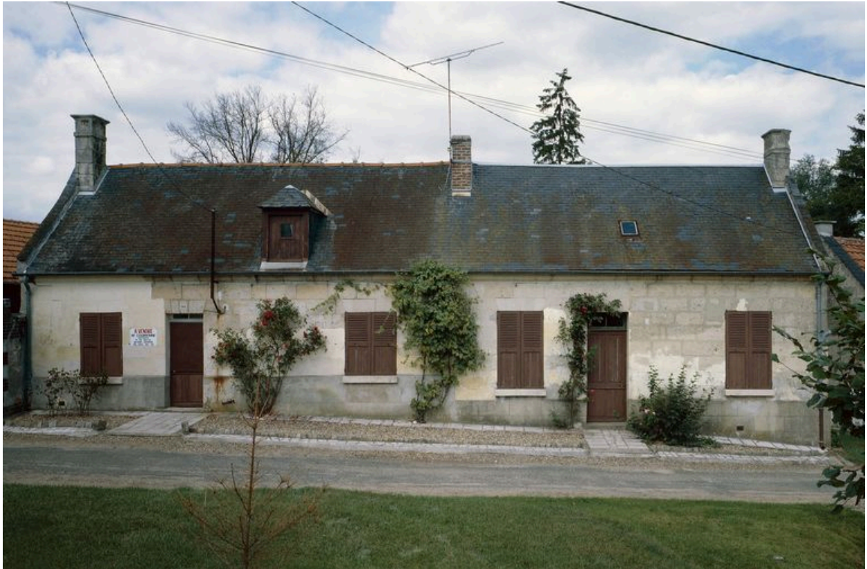
Logis. Elévation antérieure.
