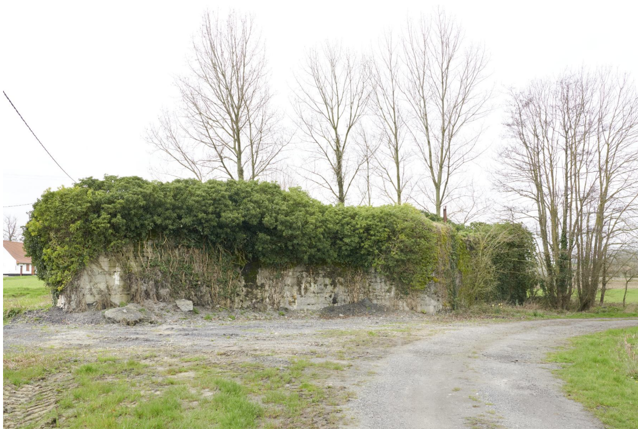
Vue de la partie nord-est de la casemate d'infanterie double CEZF-E sous couvert végétal.
