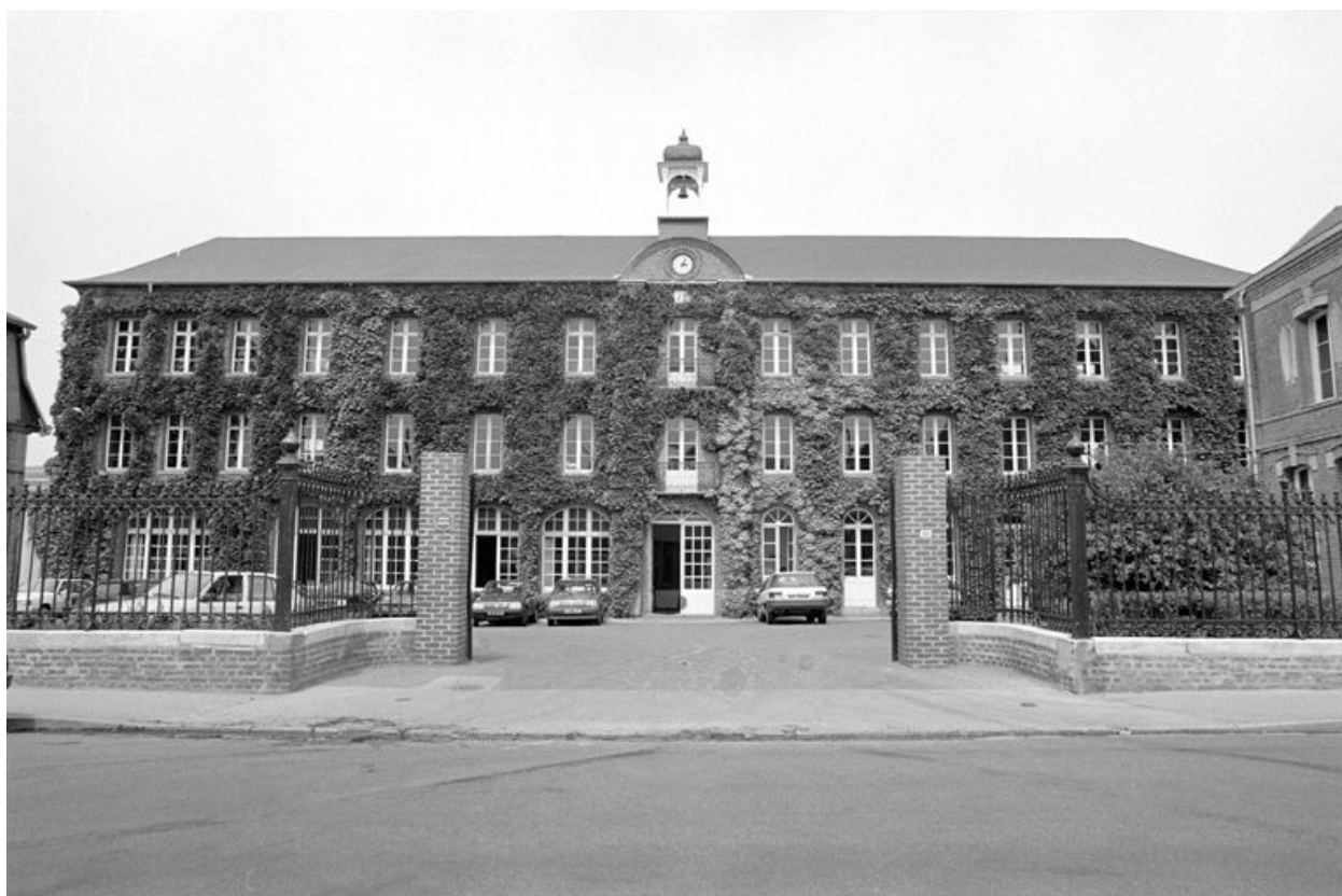
Atelier de fabrication principal, élévation antérieure, en 1990.
