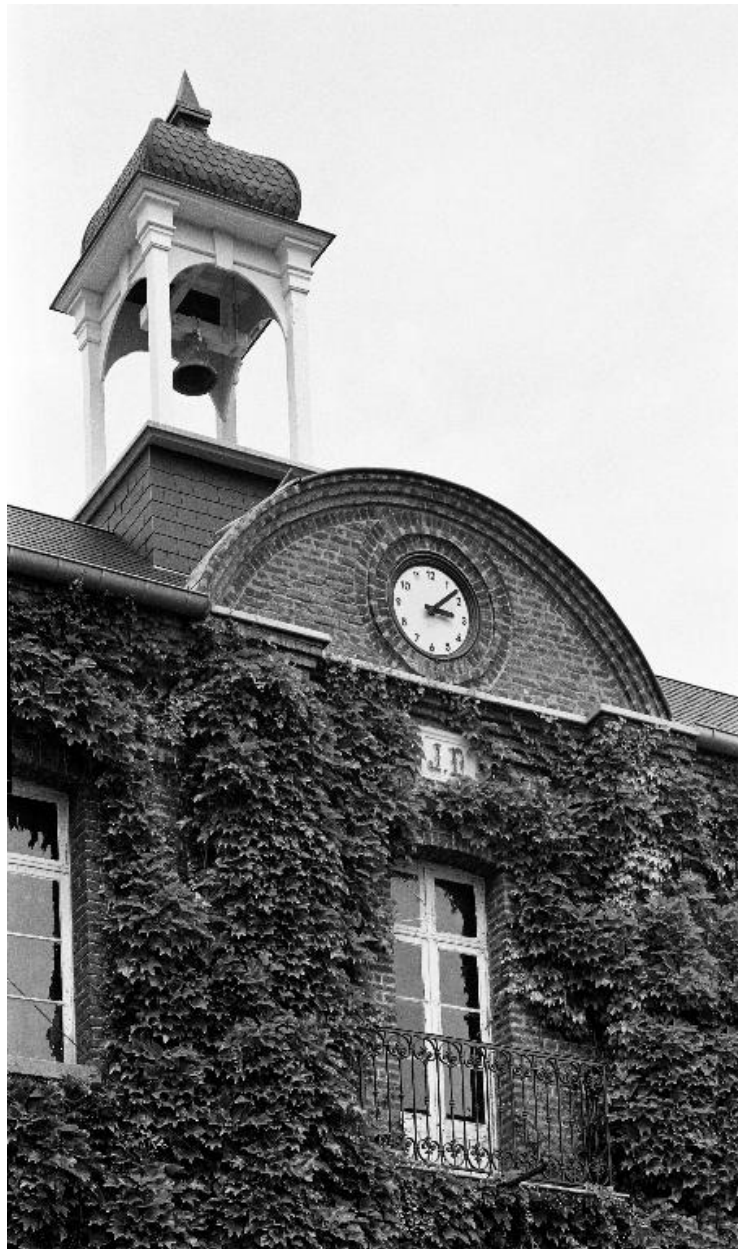
Atelier de fabrication, principal, détail, en 1990.
