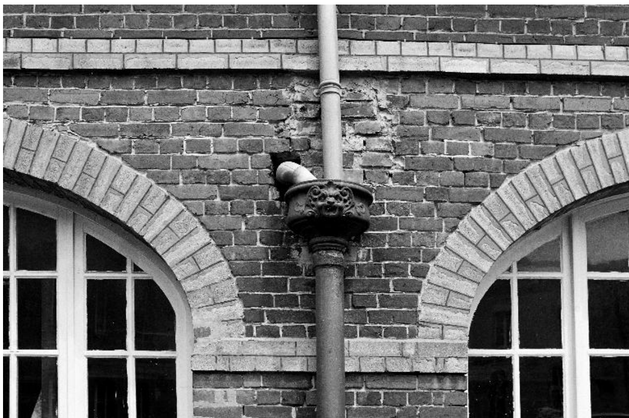
Atelier de fabrication, sud-est, détail, en 1990.
