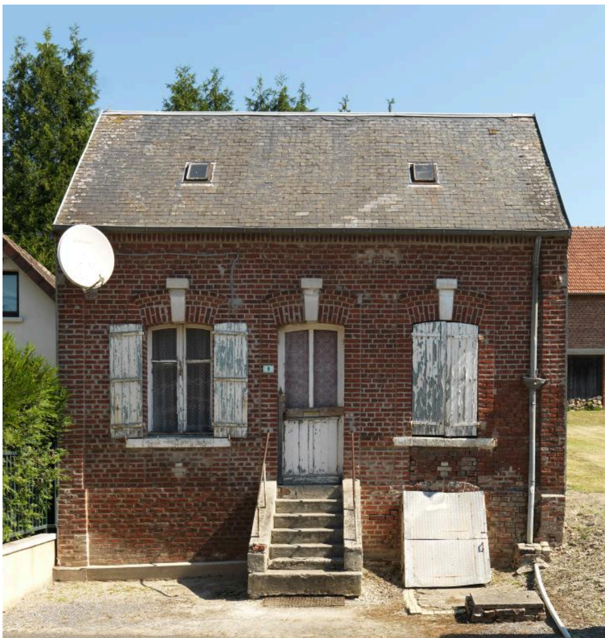
Athies. Rue du Dessous. Maison.
