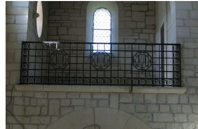
Vue de la rambarde de la tribune. Phot. Irwin Leullier IVR22_20050200924NUCA
