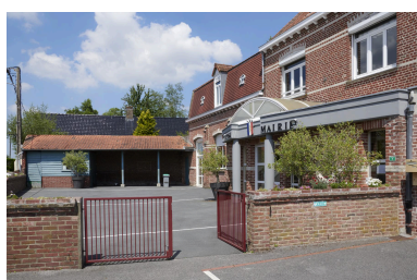
Façades et cour, portail d'entrée, le préau en arrière plan. Phot. Delphine Volto-Jourdan IVR32_20245902504NUCA
