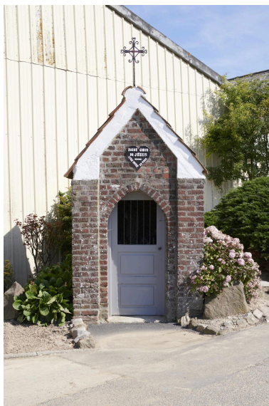
Façade principale de la chapelle. Phot. Delphine Volto Jourdan IVR32_20245902780NUCA
