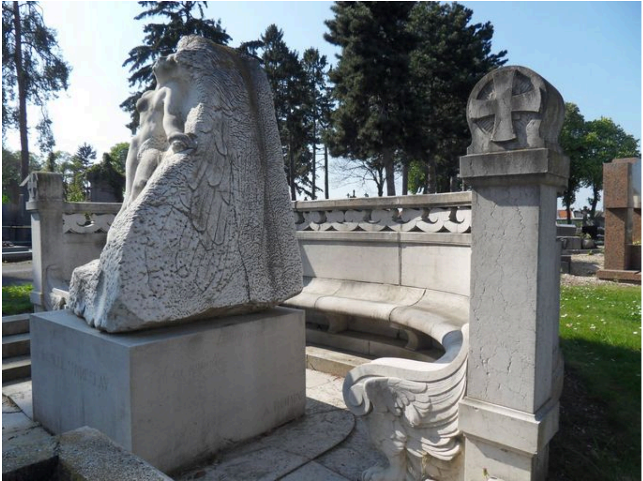
Vue depuis le sud-est.
