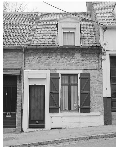
Façade sur voie. Phot. Philippe Dapvril IVR31_19946200240X
