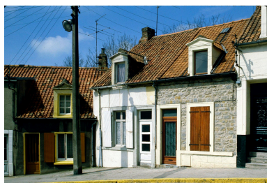
Vue d'angle sur voie. Phot. Jean-Michel Périn IVR31_19836200107ZA
