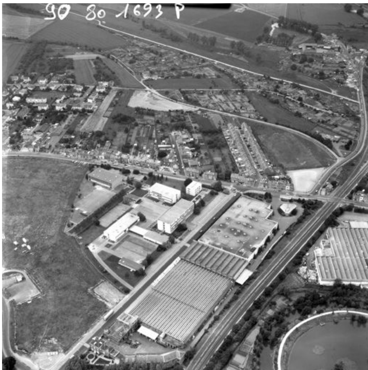
Vue aérienne, flanc sud-est.
