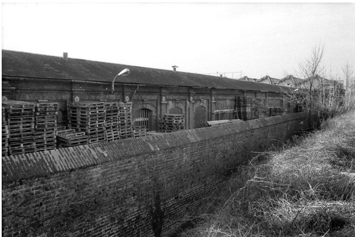
Atelier de fabrication (1), flanc est.
