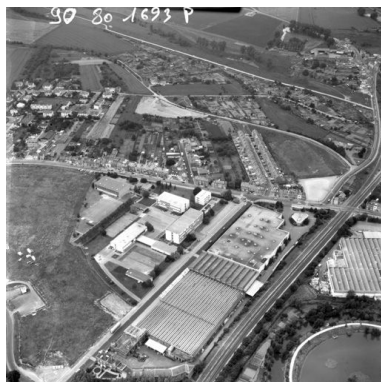
Vue aérienne, flanc sud-est. Phot. Phot'R IVR22_19908001693P
