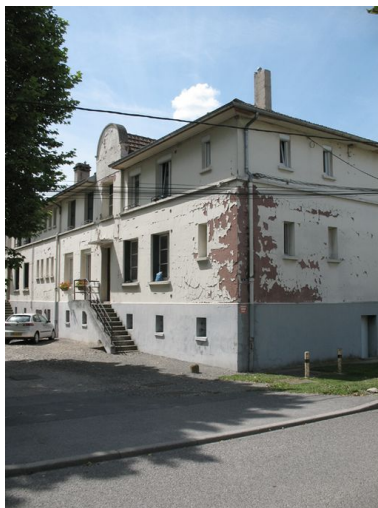
Détail du mur pignon d'une barre de logements. Phot. Clarisse Lorieux IVR22_20096005095NUCA
