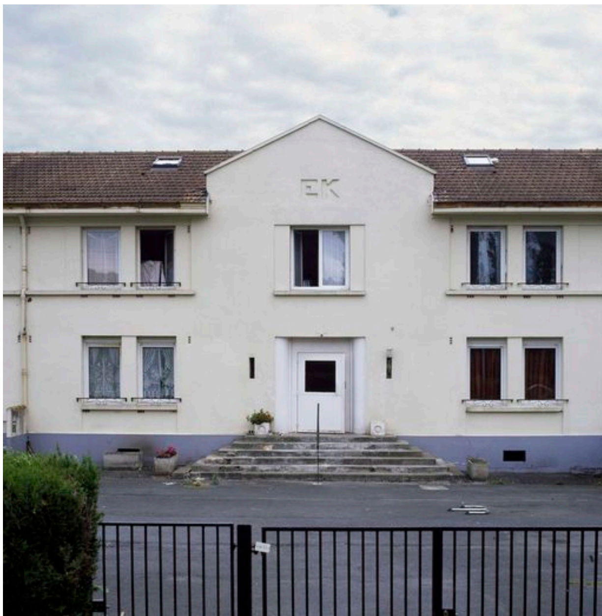
Détail de la façade portant les initiales EK.
