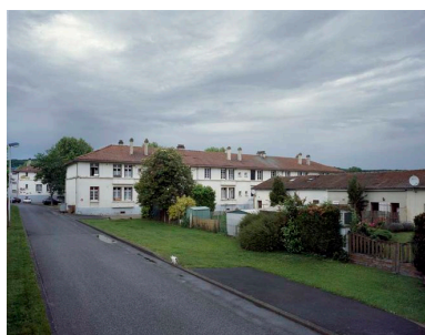
Vue générale de la cité construite en 1948.
