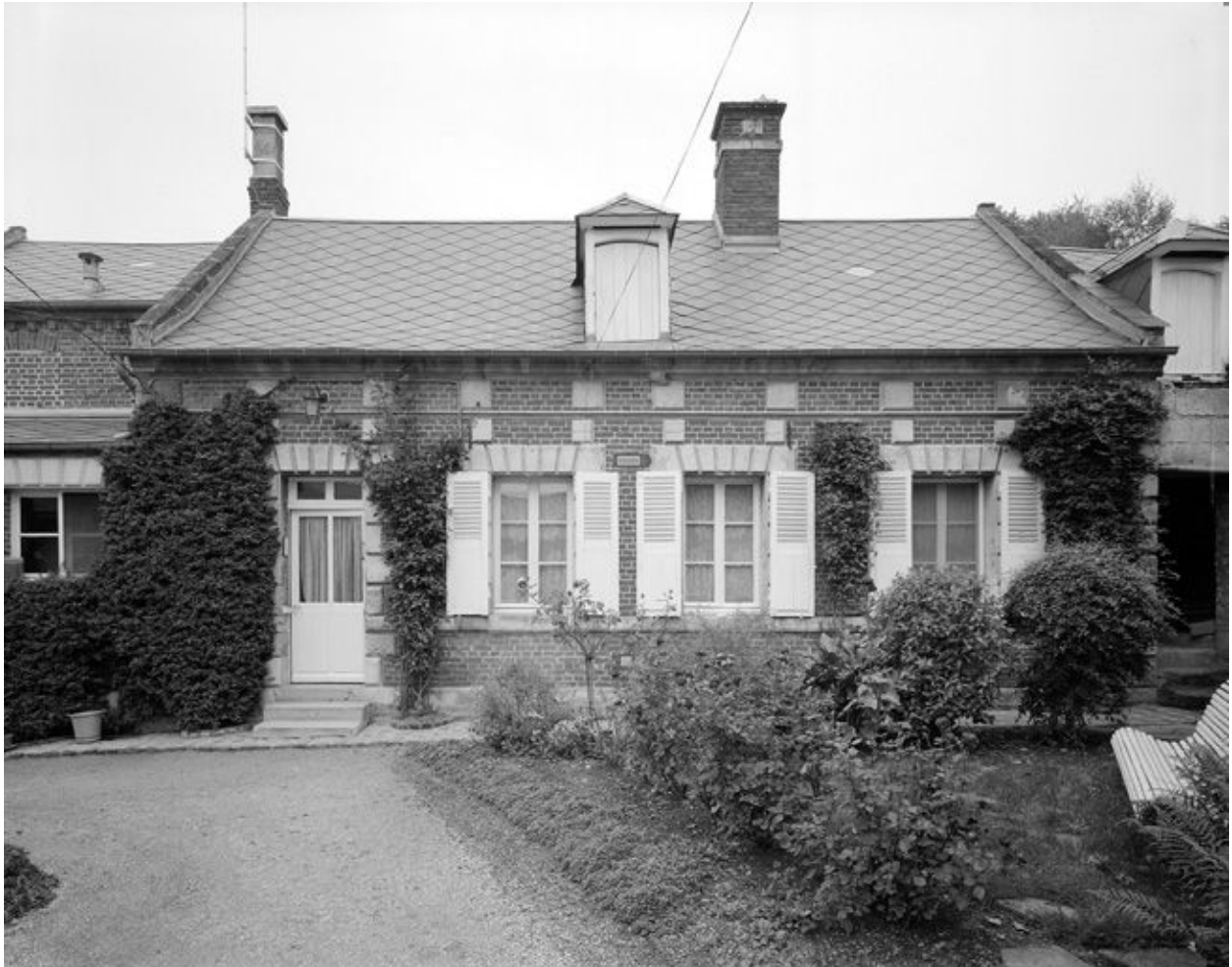
Logis. Vue générale.
