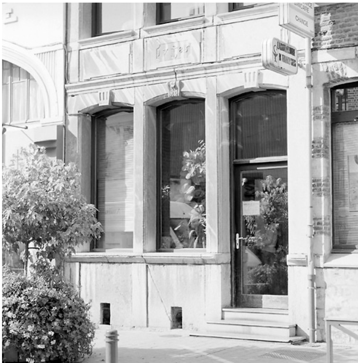
Façade, vue partielle : rez-de-chaussée.
