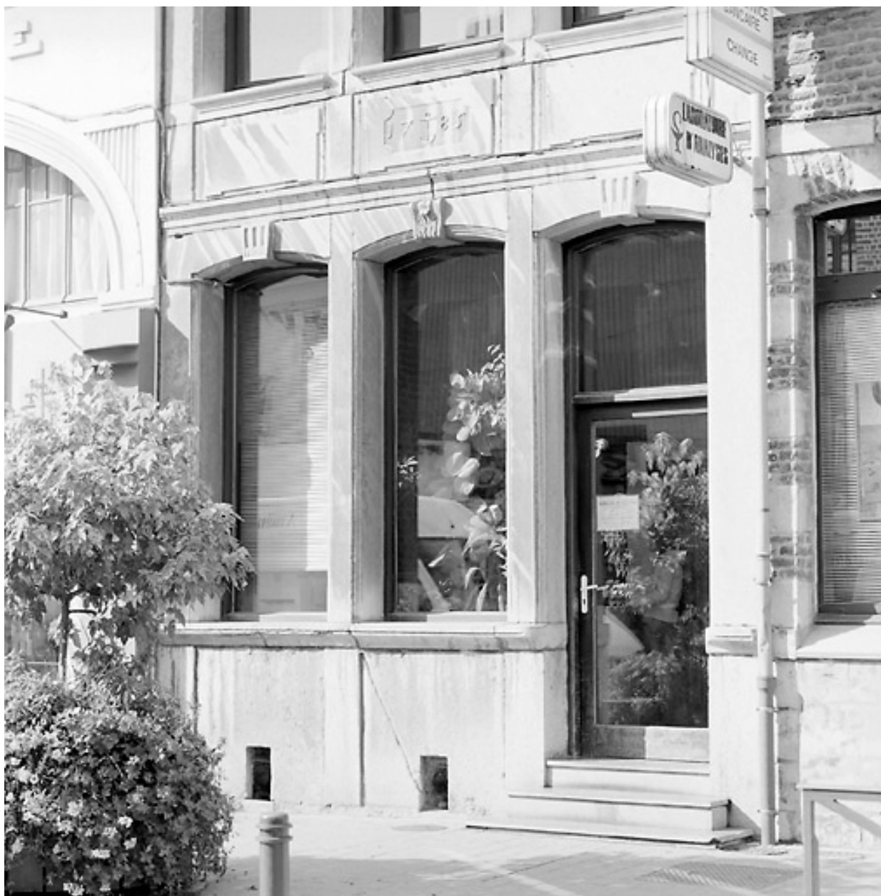
Façade, vue partielle : rez-de-chaussée.
