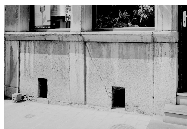
Façade, détail : soubassement et appuis de fenêtres du rez-de- chaussée ; on note l'emploi d'éléments monolithes et les traces d'outils. Phot. Pierre Thibaut IVR31_20015901233X
