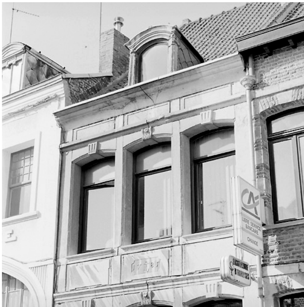
Façade, vue partielle : étage et étage de comble.
