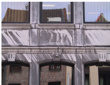
Façade, détail : allège, table sculptée portant la date de construction (1785) et l'ancre des bateliers (Conservation régionale des Monuments historiques). Phot. Olivier Liardet IVR31_20065906230NUCA
