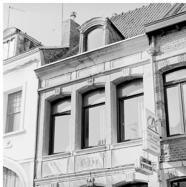
Façade, vue partielle : étage et étage de comble. Phot. Pierre Thibaut IVR31_20055900846X
