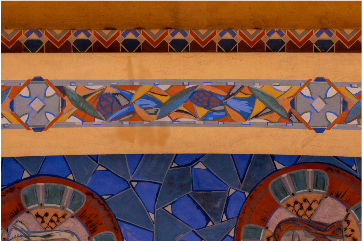
Vue de détail des motifs peints sur les arcs de la nef et des transepts bordant le chœur.
