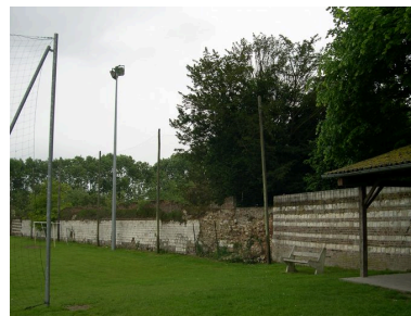
Mur de clôture, au nord de l'ancien verger de l'abbaye. Phot. Isabelle Barbedor IVR22_20038010405NUCA
