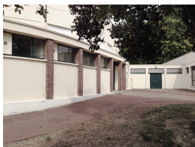
La salle des fêtes. Vue de la façade sud. Phot. Isabelle Barbedor IVR22_20158006656NUCA
