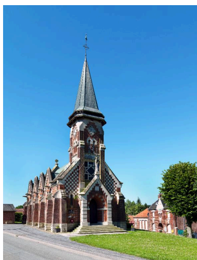
Vue générale, depuis le nord-est. Phot. Marie-Laure Monnehay-Vulliet IVR22_20128000909NUC2A
