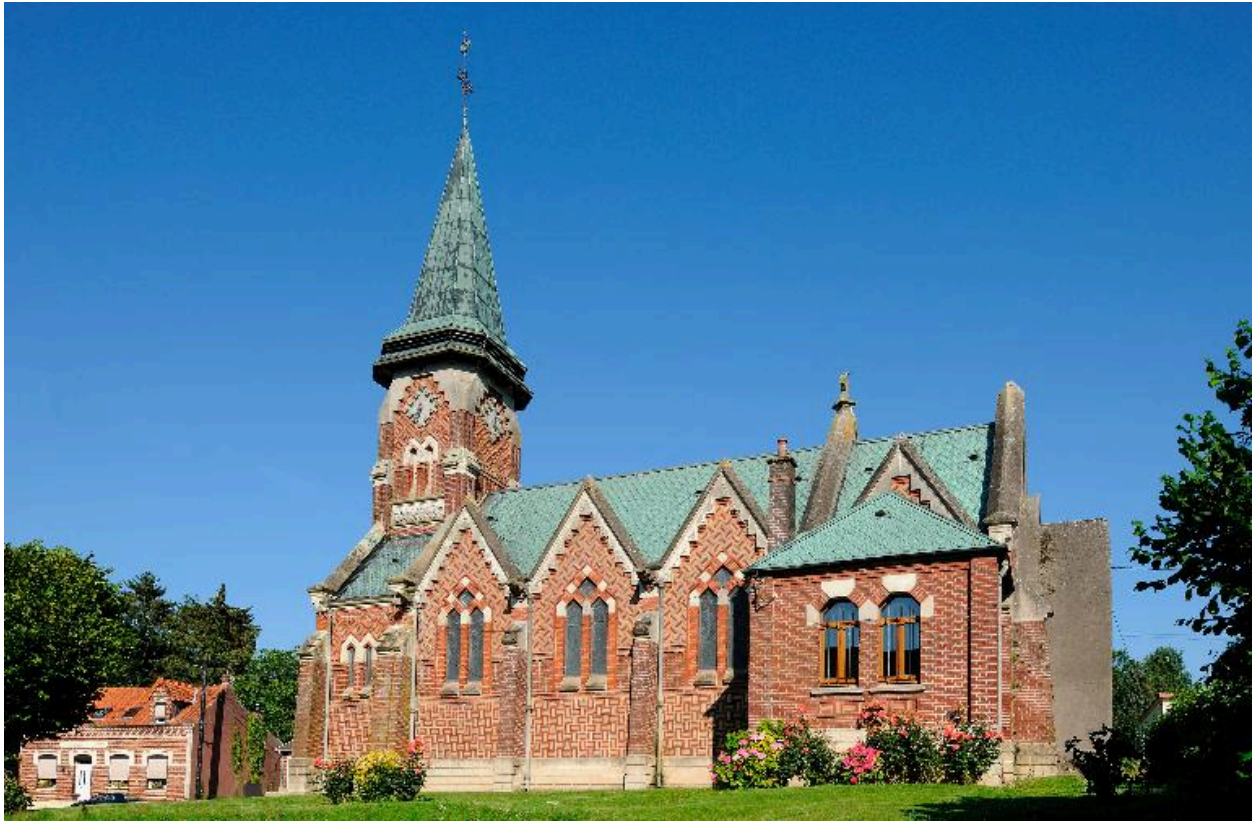
Vue de la façade sud
