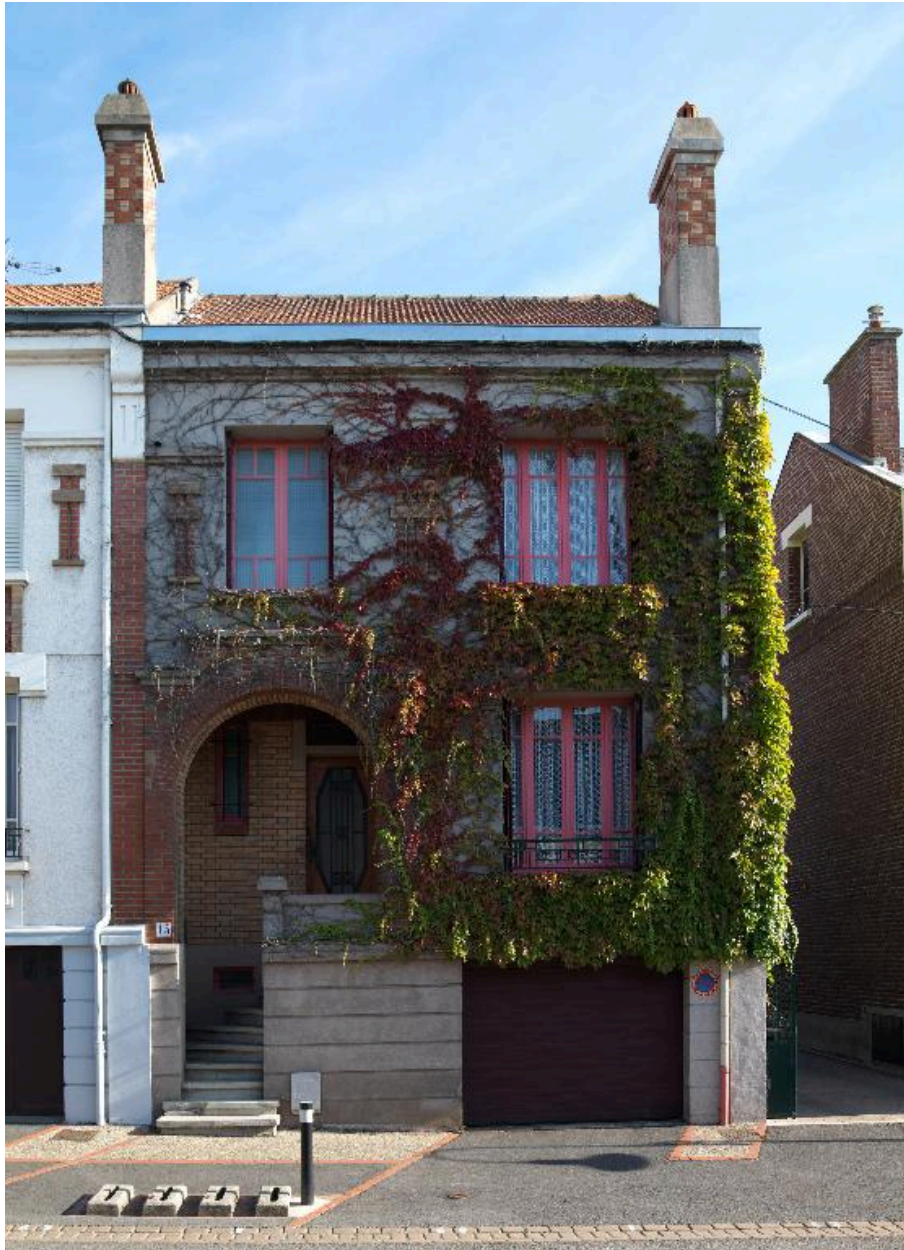
Vue de la maison, 15 rue de Noyon.
