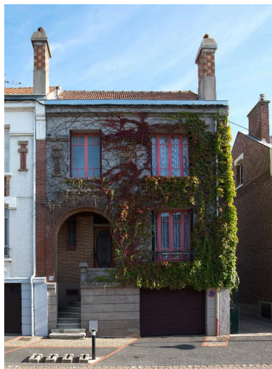
Vue de la maison, 15 rue de Noyon. Phot. Marie-Laure Monnehay-Vulliet IVR22_20158000879NUC2A
