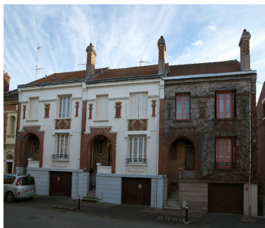
Maisons mitoyennes, 11 à 15 rue de Noyon. Phot. Marie-Laure Monnehay-Vulliet IVR22_20158001029NUC2A
