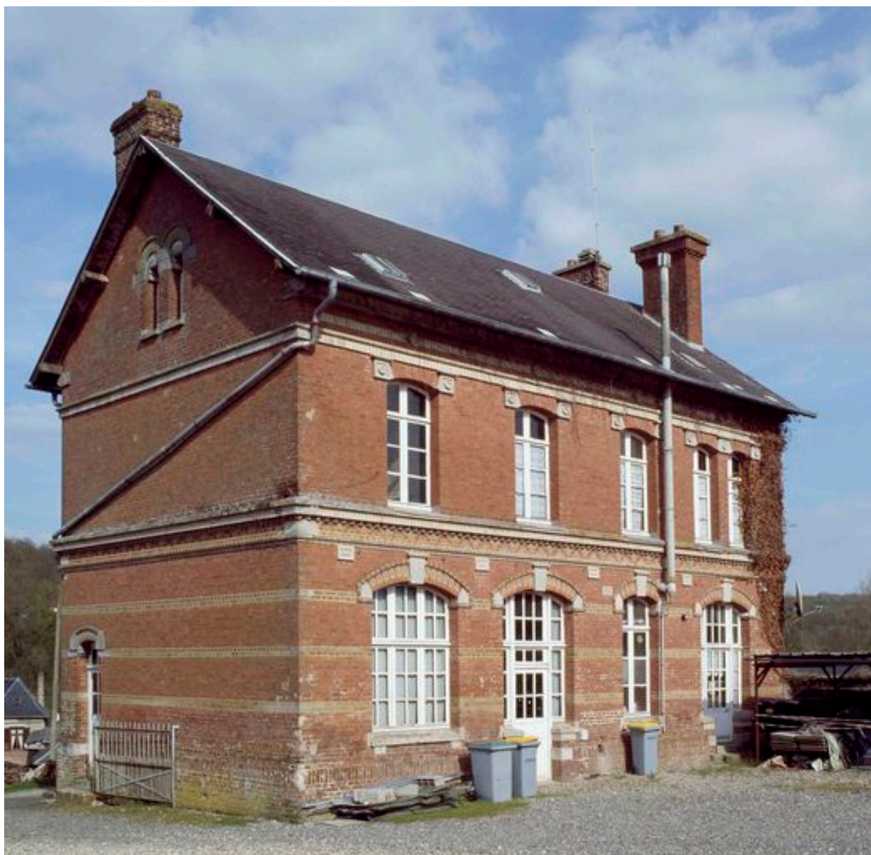
Vue de trois-quarts, depuis le nord-est, l'ancien accès à la salle de classe est visible dans le pignon.
