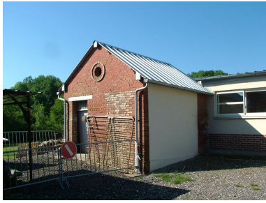
Ancien bâtiment annexe. Phot. Frédéric Fournis IVR22_20108001798NUCA
