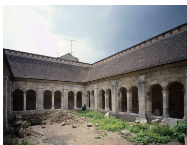
Vue du cloître de l'ancien hôtel-Dieu. Phot. Fabrice Charrondière IVR22_19866000160VA
