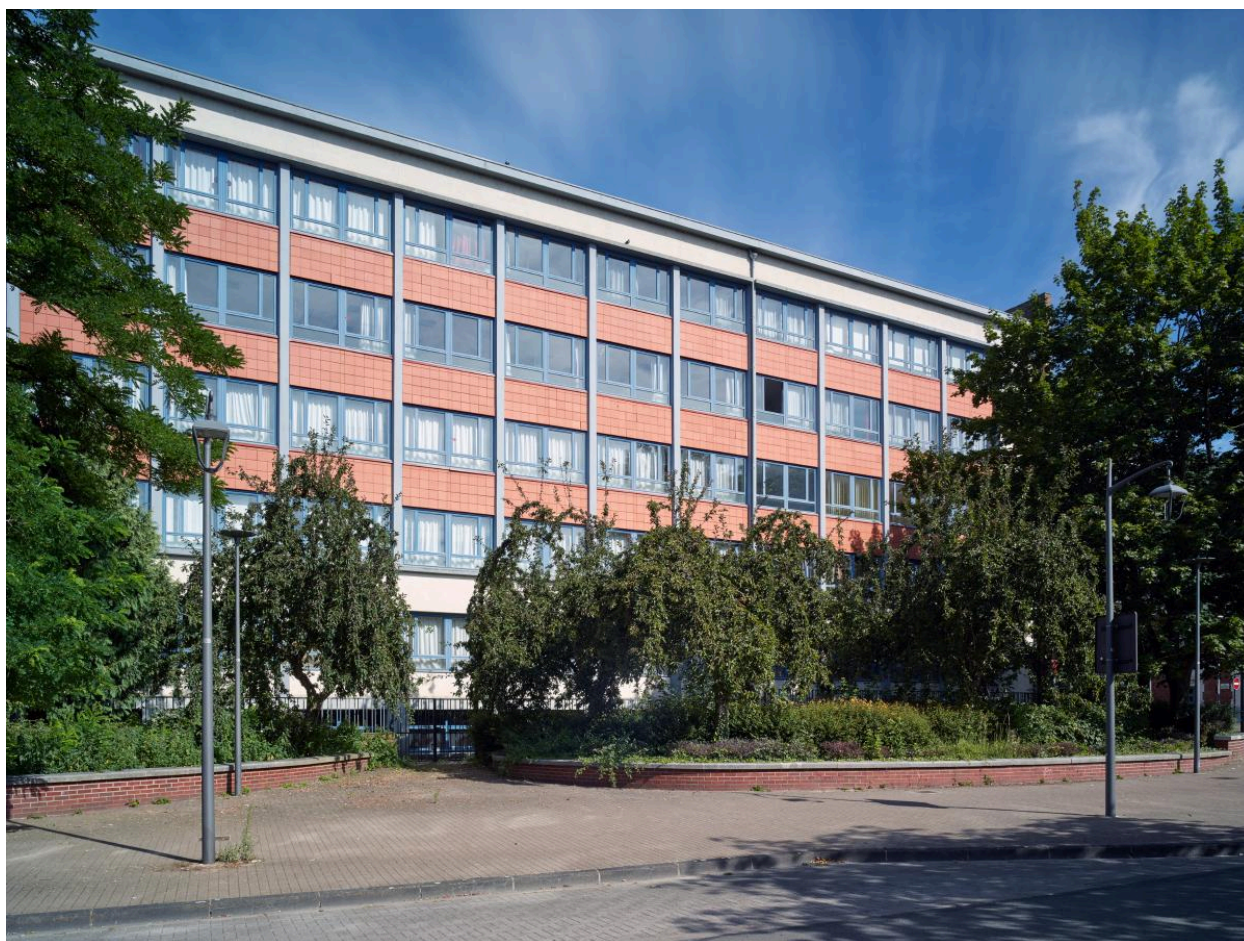
Externat : partie centrale de la façade sur l'avenue des Potiers.
