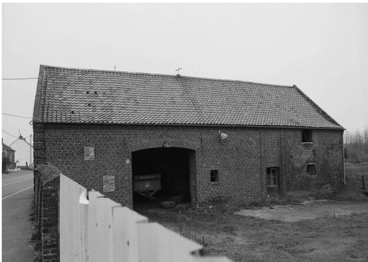
Vue générale de la grange située 869 Grand'Rue.
