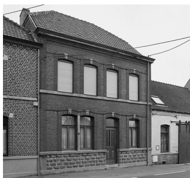
Maison, 120, Petite Rue. Phot. Philippe Dapvril IVR31_20045900019X
