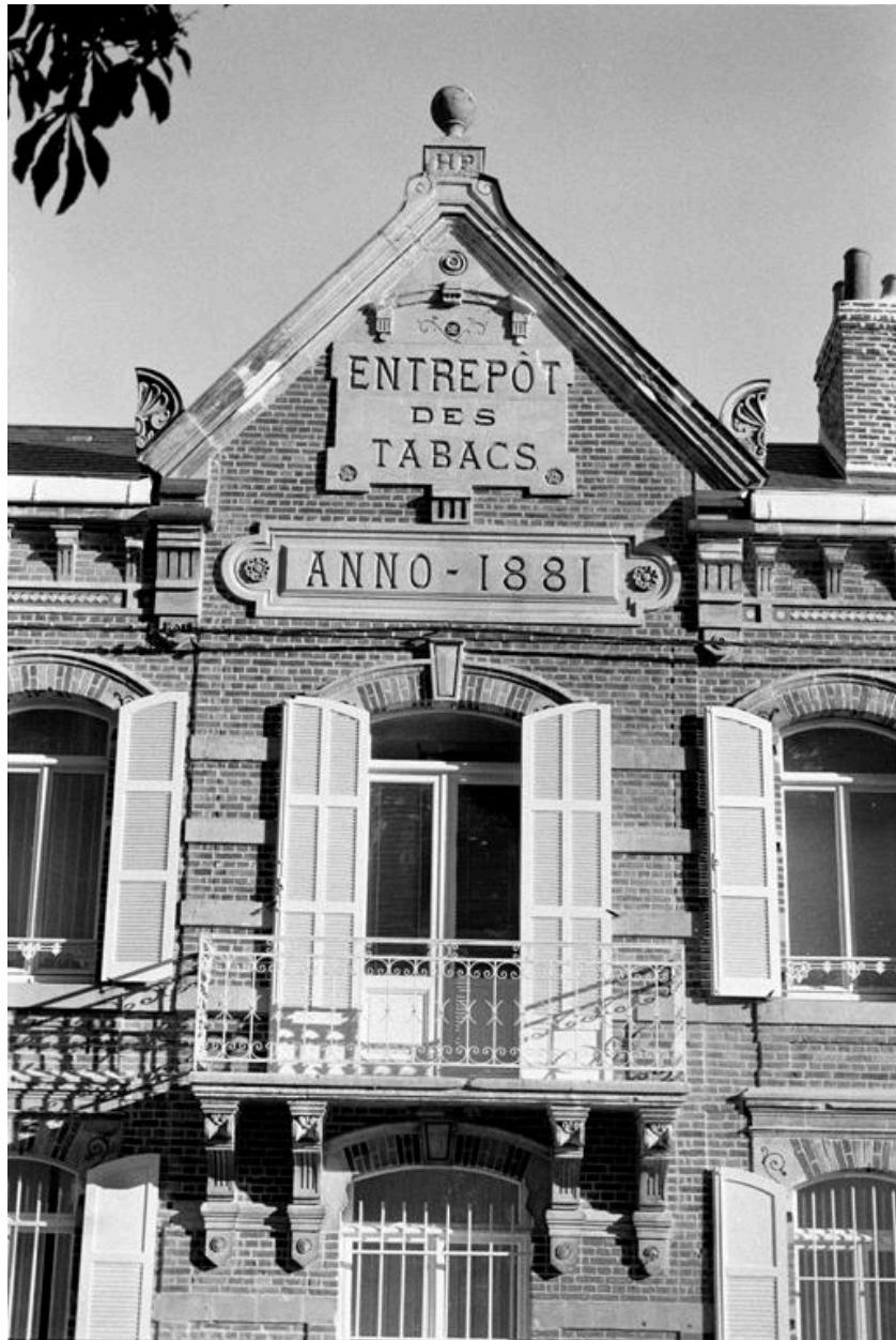
Vue du fronton de la façade principale.
