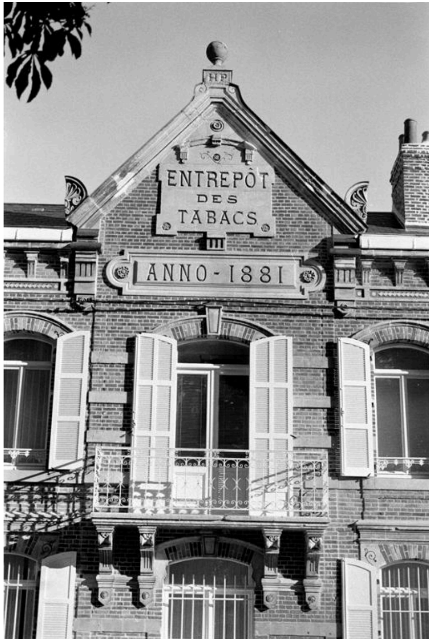
Vue du fronton de la façade principale.
