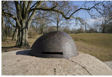
Abri casematé avec observatoire cuirassé. Détail de la coupole vers l'est. Phot. Pierre Thibaut IVR32_20235900267NUCA
